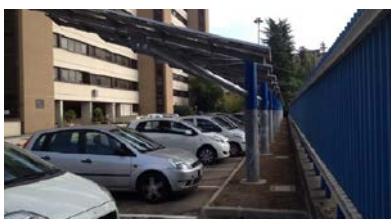
Realizzazione di un impianto fotovoltaico con pensiline di copertura
