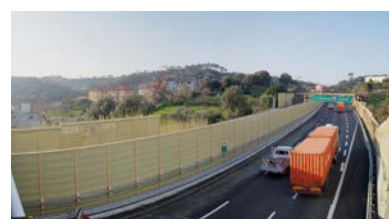
Barriere di sicurezza - spartitraffico e bordo laterale
