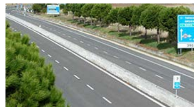
Autostrada A12 Livorno - Civitavecchia
