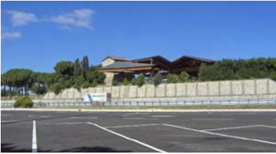
Interventi infrastrutturali nell'ambito delle Aree di Servizio
