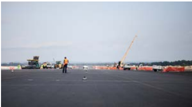
Aeroporto Leonardo Da Vinci - Fiumicino - Riqualifica delle infrastrutture di volo
