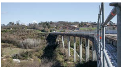
Lavoro su viadotto Bosco Grande
