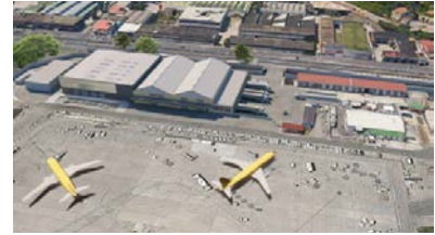
Lavori di Adeguamento Terminal Merci nell'Aeroporto di Napoli Capodichino
