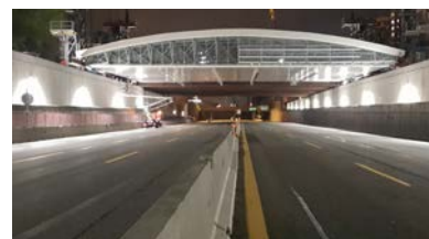
Autostrada A4 Torino - Venezia. Potenziamento alla 4 a corsia dinamica
